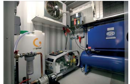
Versorgungsraum mit Kompressor
